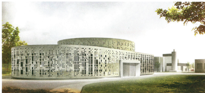
1. Preis | kister scheithauer gross: Ein 80 Millimeter dickes, gestanztes Metallband verhüllt das Laborgebäude und den runden Dachaufbau
