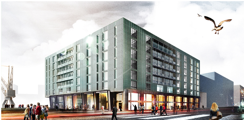
Dunkler Stahl und glasierte Keramik verleihen dem Gebäude eine ästhetische Eigenständigkeit. (©ksg)
