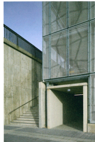
Einfahrtsituation © Yohan Zerdoun
