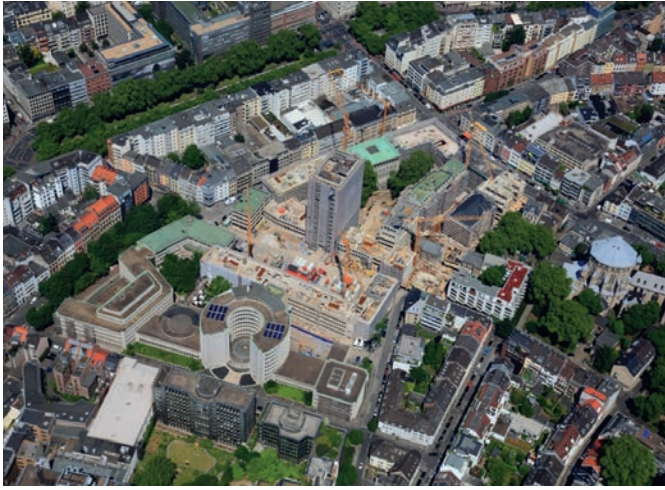
Bild 2. Das 4,6 ha große Gerling-Areal mitten in Köln steht heute unter Denkmalschutz
