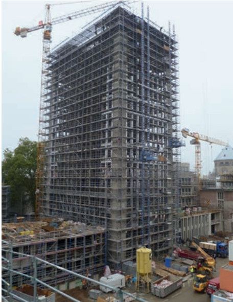
Bild 4. Das in der seinerzeit innovativen Stahl-Skelettbauweise errichtete Hochhaus musste bis auf sein nacktes Stahlskelett komplett entkernt und von Grund auf neu „befüllt“ werden (Fotos 2 und 4: Immofinanz)
