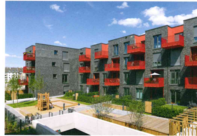
Bild 2. Die knallrot gestrichenen Balkonelemente geben dem Bau ein außergewöhnliches Gesicht; gemeinschaftlich genutzte Flächen verstärken den urbanen Charakter des gesamten Projektes.
