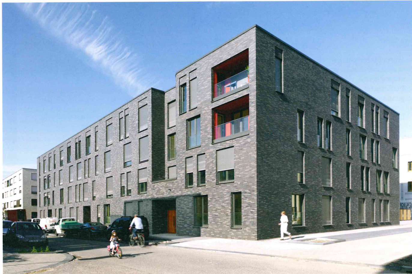
Bild 1. Das CLOUTH 3 – ein funkelnder schwarzer „Rohdiamant“ auf dem Areal der ehemaligen Gummiwarenfabrik Clouth
